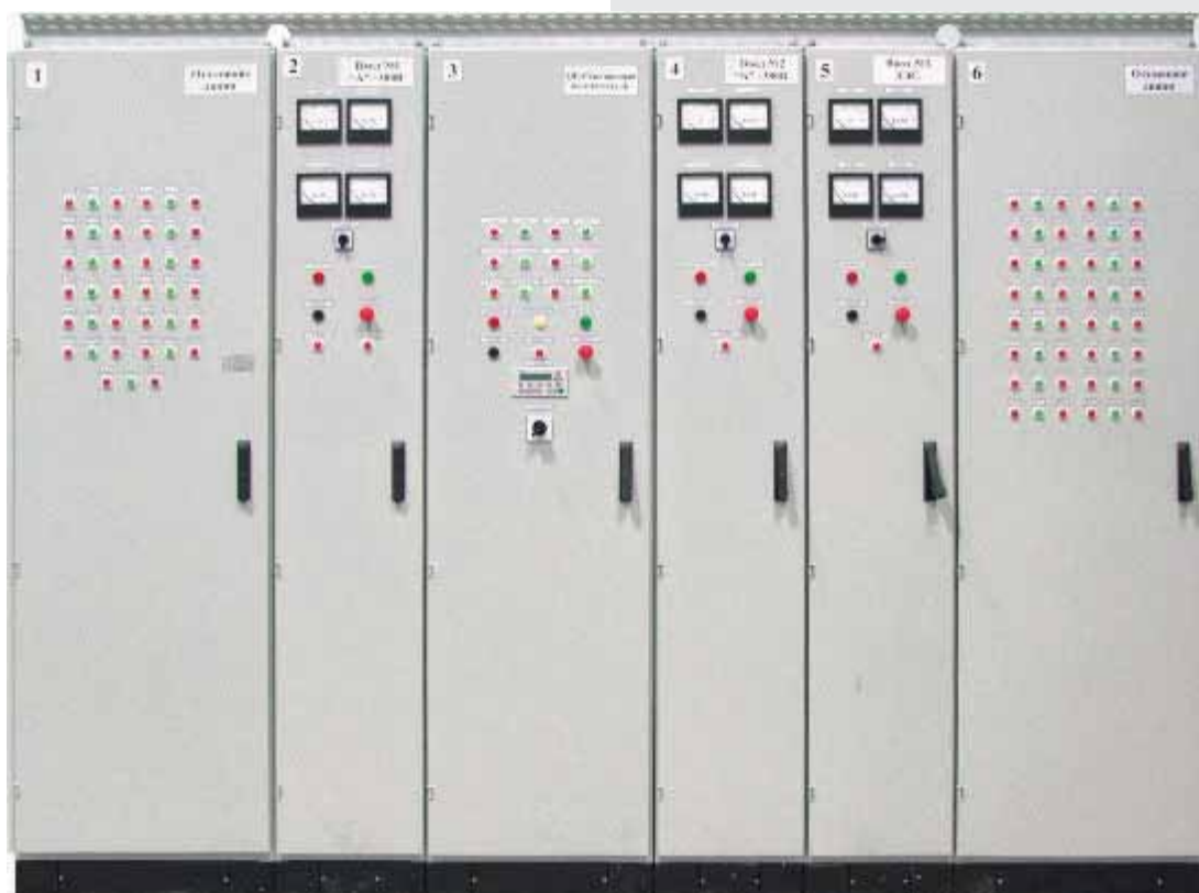
Шкафы автоматического ввода резерва (АВР) на базе микропроцессорных контроллеров
